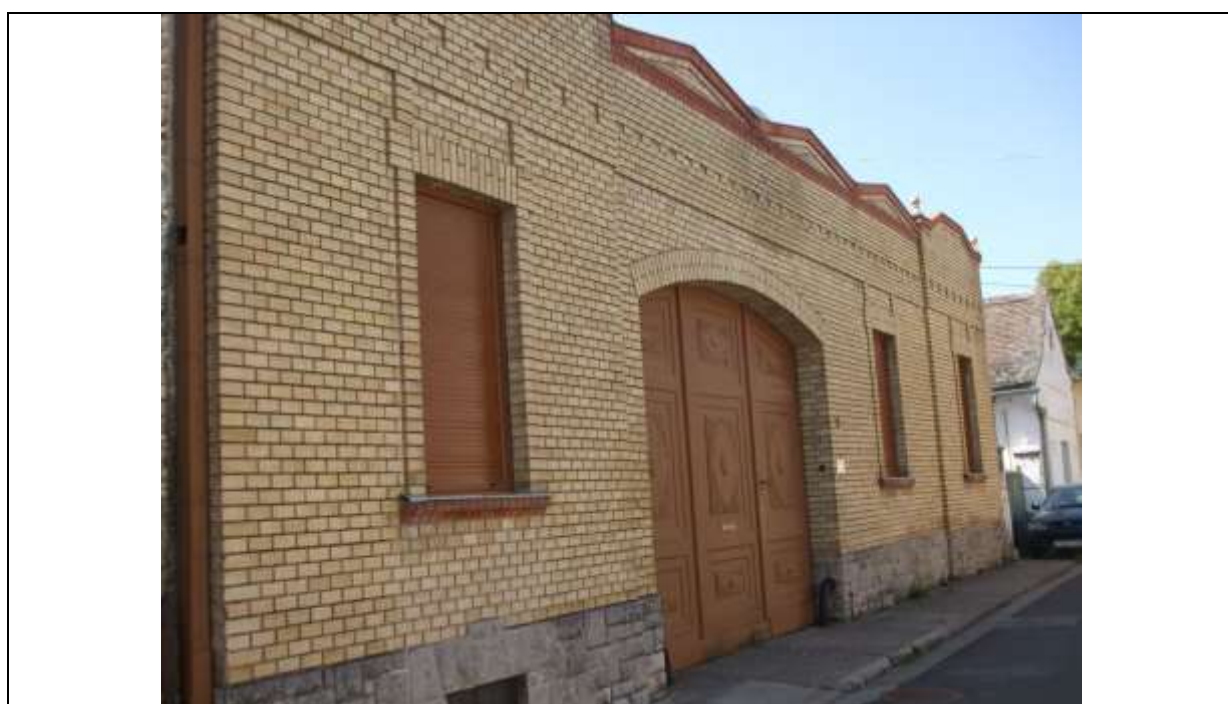
Szappanos téglás szecessziós jegyeket viselő lakóház. Különleges karaktere egyedi jelleget kölcsönöz, magasra emelt, geometriai alakzatokkal díszített homlokzata igazán különlegessé teszi.
